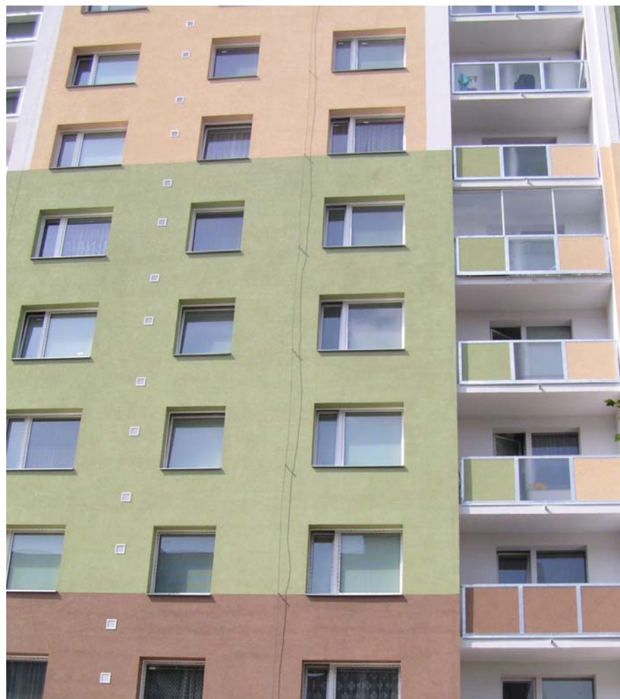
Rekonštruovaný panelový dom, Svitavy
