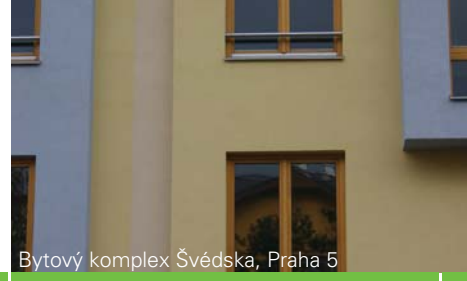
Bytový komplex Švédská, Praha 5
